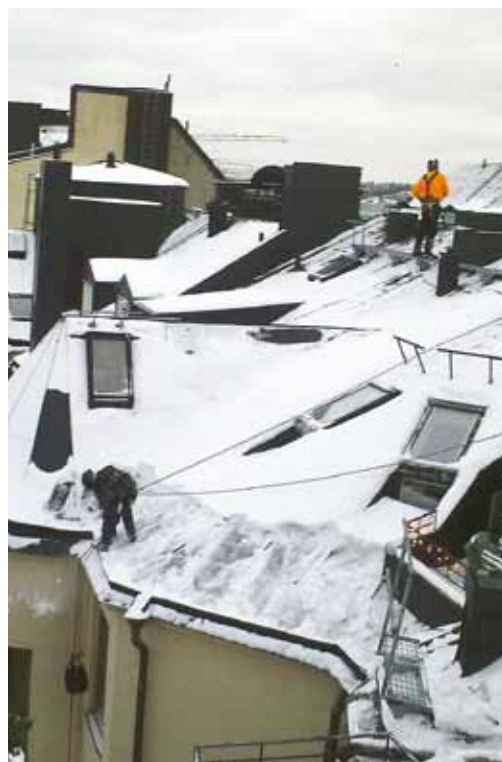
På grund av okunskap och slarv orsakar takskottning eller bristen på skottning, skador för mångmiljonbelopp varje år.
