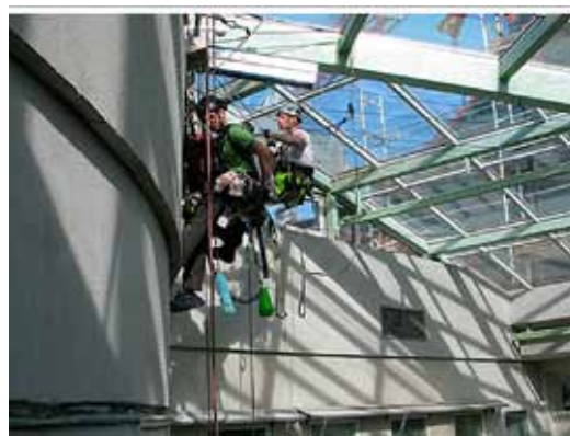
Rengöring av glastaket på en innergård på Akademiska sjukhuset i Uppsala.
